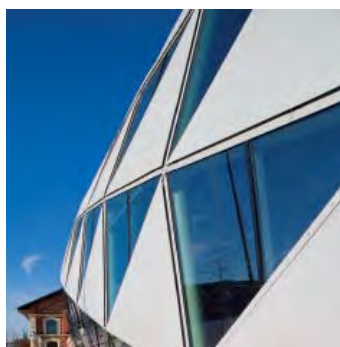
pic_07: Die äußere Hülle wurde in einschaliger Bauweise direkt auf die stählernen Rundrohre der Primärkonstruktion aufgebracht.
