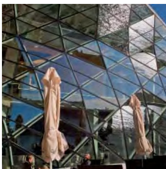
pic_09: Fassadenabschnitte, die nicht über einem Fluchtweg liegen, wurden mit nicht brennbaren Materialien realisiert. Die vorbeifließende Donau spiegelt sich in den großen Glasflächen.
