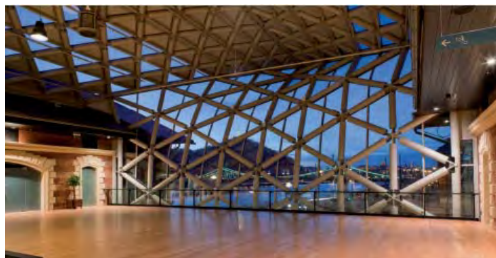
pic_06: Für den Brandschutz sorgt – u.a. – eine raffinierte Konstruktion aus dem Spezialglas PYRAN® S von SCHOTT Technical Glass Solutions, Jena.
