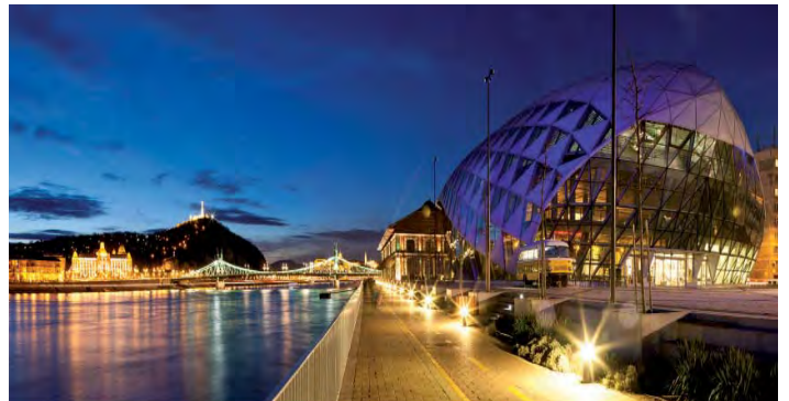
pic_02: In prominenter Lage Budapests bereichert eine fantasievolle Bauskulptur die Silhouette der Donaumetropole. Die Fassade bilden insgesamt 405 großformatige Isolierglaselemente aus dem Spezialglas PYRAN® S im Wechsel mit dreieckigen Aluminium-Sandwichpaneelen und Glaselementen ohne Brandschutzanforderung.
