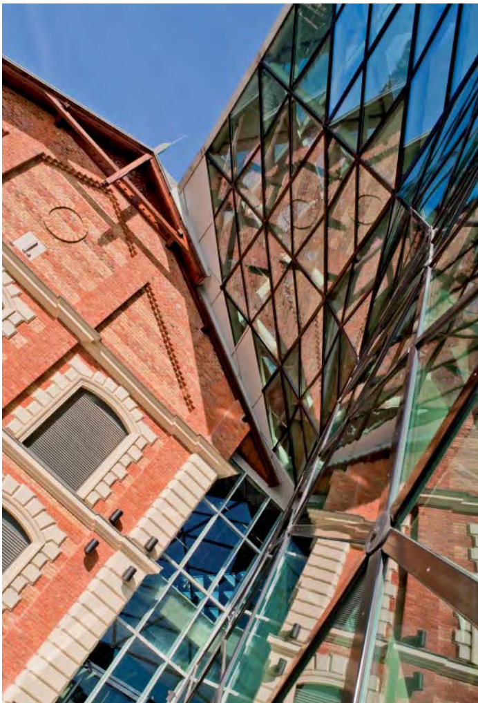
pic_01: Reizvolle Spiegelung an der Schnittstelle der denkmalgeschützten Lagerhalle mit der neuen Stahl-Glas-Konstruktion.
