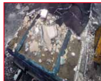
Entfernen der Beplankung
