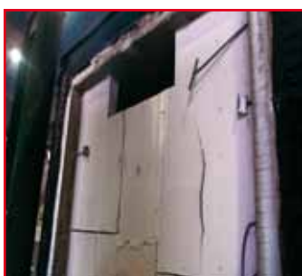
Prüfkörperansicht nach der Prüfung (oben)
