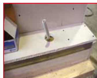
Beplankungsarbeit (Kabeldurchführung)
