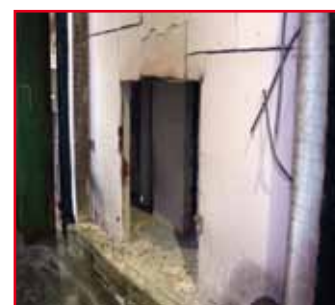
Prüfkörperansicht nach der Prüfung (unten)
