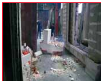
Prüfkörper nach Prüfende (herausgekippt)
