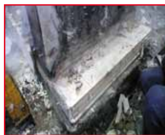
Entfernen der Beplankung
