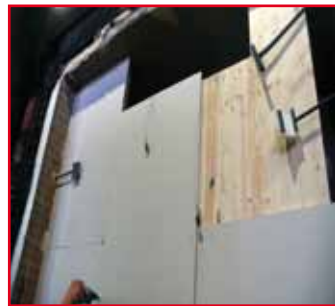
Oberer Teil während der Beplankung
