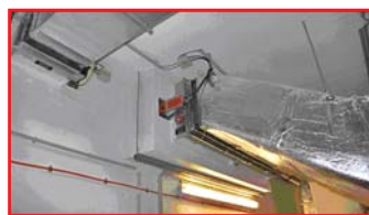
Photo 11 und 12: Beispielhafte Ansichten von „hart“ verkleideten und „weich“ abgeschotteten BSK mit Segeltuchstützen als Dehnungskompensation sowie Überbrückung der elektrisch nicht leitenden Segeltuchstützen durch Montage von Erdungsdrähten.
