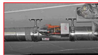
Photo 3 bis 8: ordnungsgemäß kraftkompensierte BSK/BRK vor Montage der weichen Abschottung
