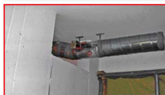
Photo 3 bis 8: ordnungsgemäß kraftkompensierte BSK/BRK vor Montage der weichen Abschottung
