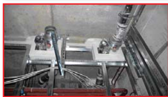
Photo 23 bis 26: Beispielhafte Ansichten von optimal befestigten, dehnungskompensierten u. abgeschotteten BSK vor Errichtung bzw. Beplankung der Ständer-, Trenn- oder Schachtwand.
