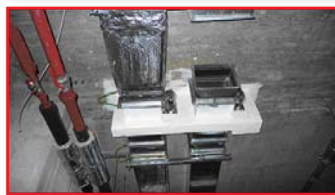
Photo 23 bis 26: Beispielhafte Ansichten von optimal befestigten, dehnungskompensierten u. abgeschotteten BSK vor Errichtung bzw. Beplankung der Ständer-, Trenn- oder Schachtwand.
