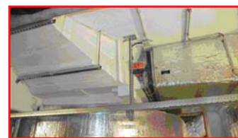
Photo 11 und 12: Beispielhafte Ansichten von „hart“ verkleideten und „weich“ abgeschotteten BSK mit Segeltuchstützen als Dehnungskompensation sowie Überbrückung der elektrisch nicht leitenden Segeltuchstützen durch Montage von Erdungsdrähten.
