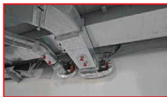
Photo 19 und 20: Beispielhafte Ansicht von thermisch isolierten BSK mit und ohne Abschottung
