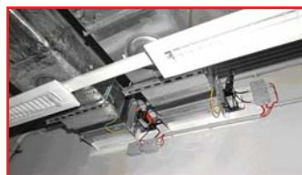
Photo 1 und 2: ordnungsgemäß hergestellter Potentialausgleich an Lüftungsleitungen/BSK mit Dehnungskompensation – Überbrückung des elektrisch nicht leitenden Segeltuchstützens durch Montage von Erdungsdrähten.
