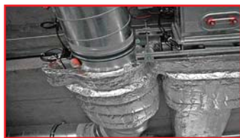
Photo 19 und 20: Beispielhafte Ansicht von thermisch isolierten BSK mit und ohne Abschottung
