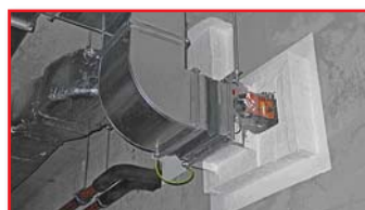
Photo 9 und 10: Beispielhafte Ansichten von „weich“ verkleideten und abgeschotteten BSK mit Segeltuchstützen als Dehnungskompensation sowie Überbrückung der elektrisch nicht leitenden Segeltuchstützen durch Montage von Erdungsdrähten.
