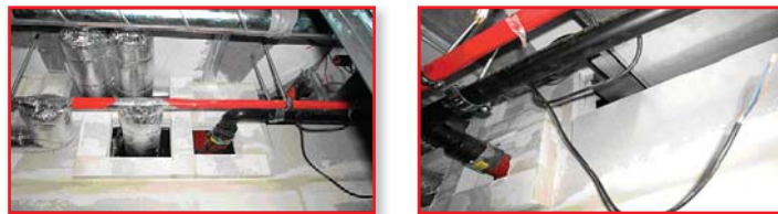
Photo 17 und 18: beispielhafte Ansichten von krantzörmigen Aufdoppelungen von Durchbruchöffnungen in 40 mm dicken Schachtwänden - Dicke der aufgedoppelten Schachtwand - 80 mm.
