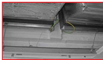
Photo 21 und 22: Beispielhafte Ansicht von abgeschotteten BSK mit kranzförmiger Aufdoppelung
