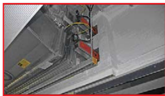
Photo 21 und 22: Beispielhafte Ansicht von abgeschotteten BSK mit kranzförmiger Aufdoppelung
