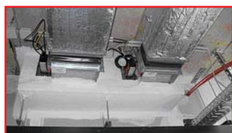
Photo 9 und 10: Beispielhafte Ansichten von „weich“ verkleideten und abgeschotteten BSK mit Segeltuchstützen als Dehnungskompensation sowie Überbrückung der elektrisch nicht leitenden Segeltuchstützen durch Montage von Erdungsdrähten.
