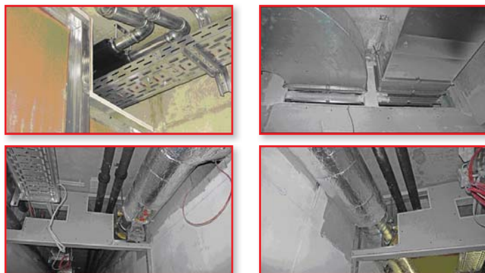
Photo 13 - 16: Beispielhafte Ansichten von ertüchtigten Durchbruchlaibungen in Ständerwänden mit einer Konstruktionsdicke von 100 mm
