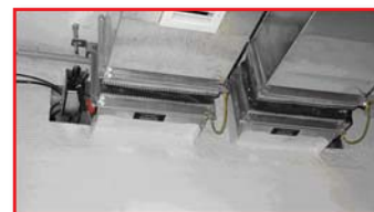
Photo 1 und 2: ordnungsgemäß hergestellter Potentialausgleich an Lüftungsleitungen/BSK mit Dehnungskompensation – Überbrückung des elektrisch nicht leitenden Segeltuchstützens durch Montage von Erdungsdrähten.
