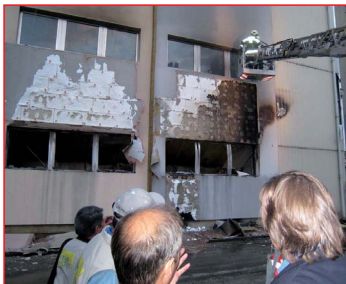
Naturbrandversuch an einer Styropor-Fassade.
